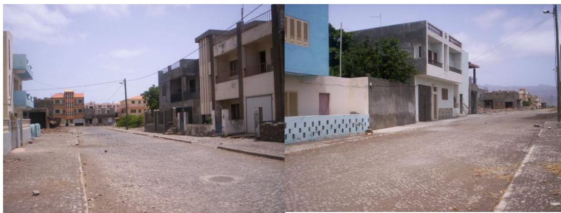
Fotos: 7 e 8: Edifícios característicos de Achada Baixo – Vila do Tarrafal, Maio de 2005
